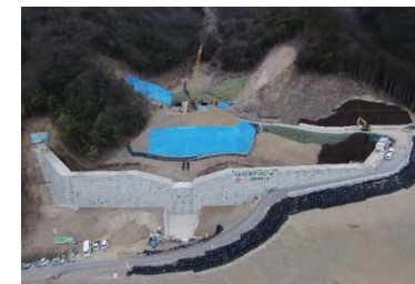
【作業ヤード完成】
