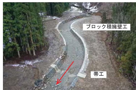
写真2 4・5工区完成写真
