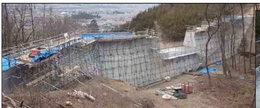
仮設足場を使用している作業状況 バイブレーター先端作業員
