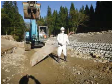
写真12 被災状況（訓練）
