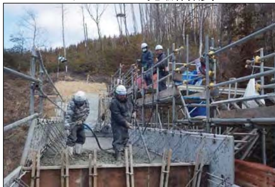
仮設足場を使用している作業状況 バイブレーター先端作業員
