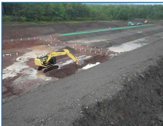
写真-5 立入禁止措置 (カラーコーン)
