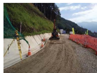
【ICT建機による路盤敷均し】
