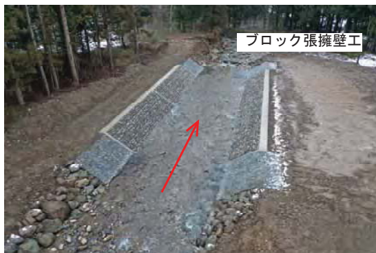
写真1 3工区完成写真
