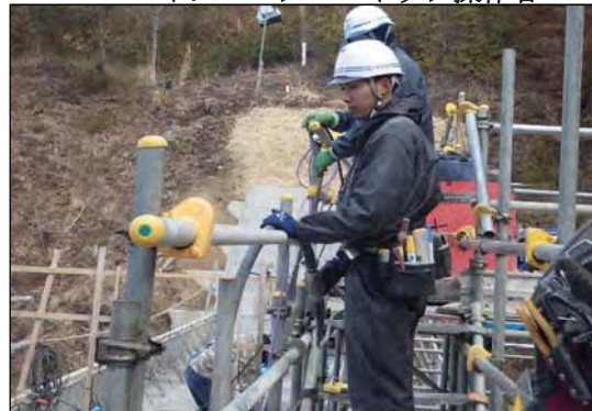
仮設足場を使用している作業状況 バイブレータースイッチ操作者
