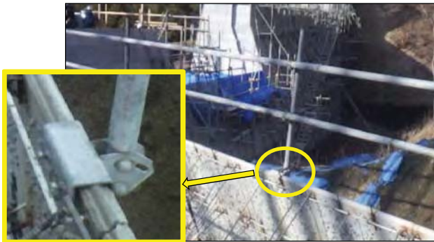
堤体中間地点：専用金具を用いて転落防止施設設対策実施
