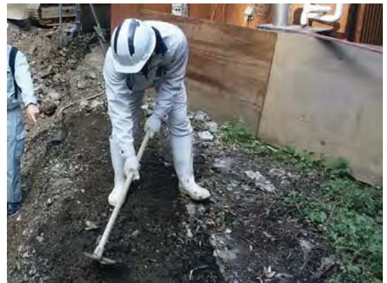
写真-5 人力作業状況
