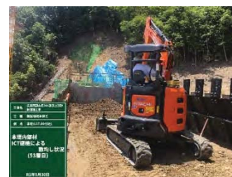
【ICT建機による本堤内部材敷均し】
