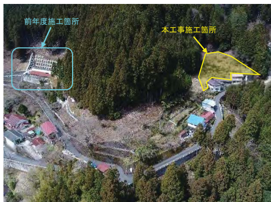
図-1 殿野地区施工箇所周辺状況
