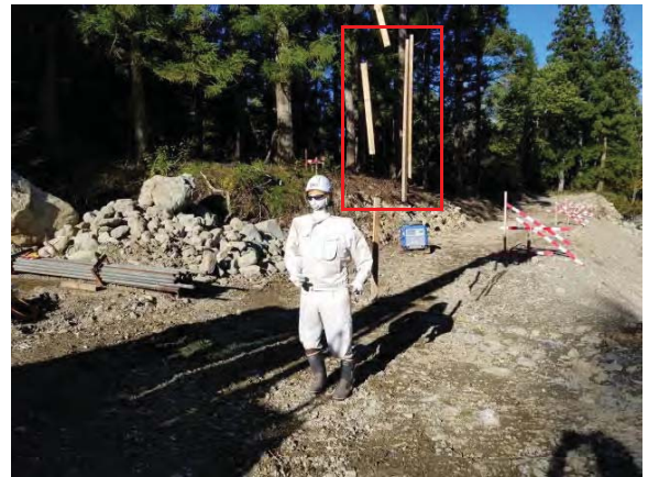
写真8 実際に資材が落下する
