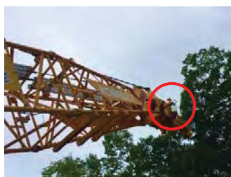
【カメラ取付状況】
