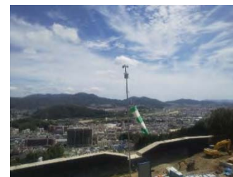
【風速計設置状況】
