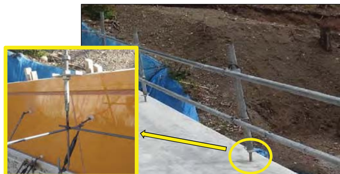
堤体天端：ステッキアンカー、シーボルトを利用し転落防止施設設置対策
