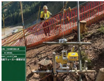
写真-18 法面ウォーカー
