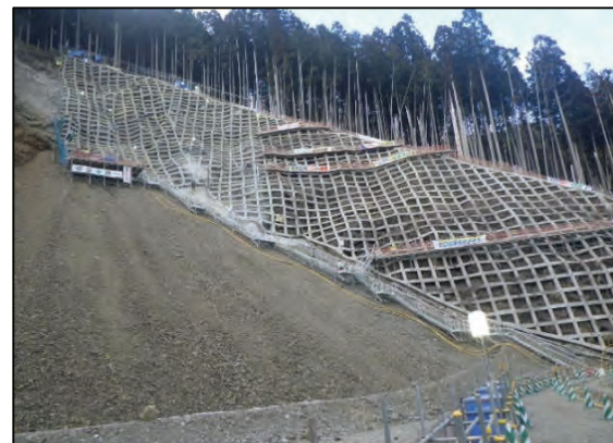
写真-1 施工状況
