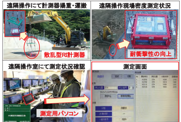
図-12 現場密度測定状況(遠隔操作室)
