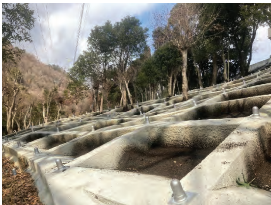
■ 写真-1 北工区：斜面西側より撮影
