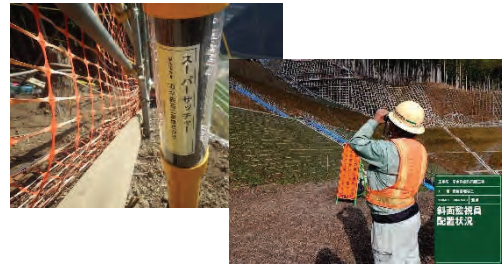
写真-3 土砂崩壊対策
