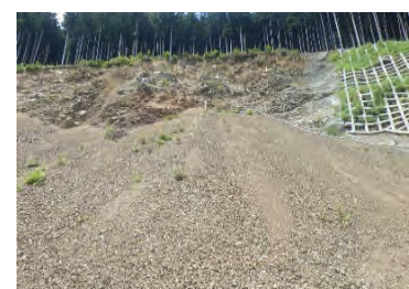
写真-2 施工前状況
