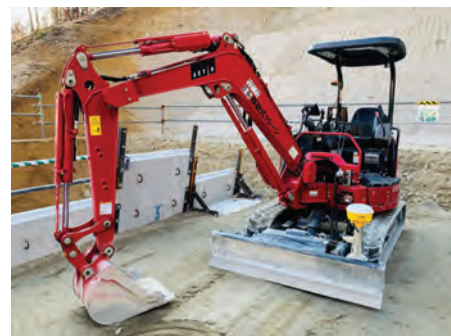
【GNSS MC ブレードコントロール ICT 建機】
