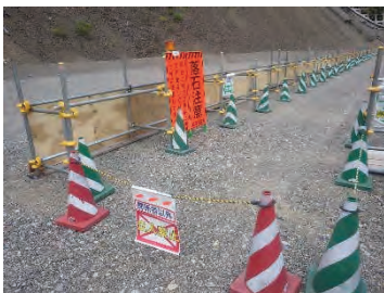
写真-6 作業通路
