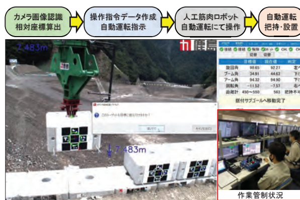
図-9 ブロック設置の自動化施工状況
