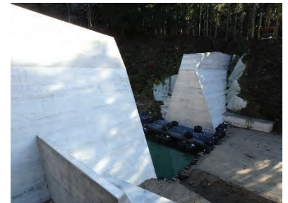
写真-2 工事完成
