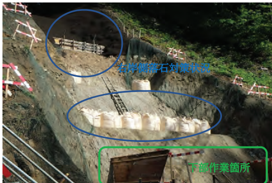
右岸側落石対策状況
