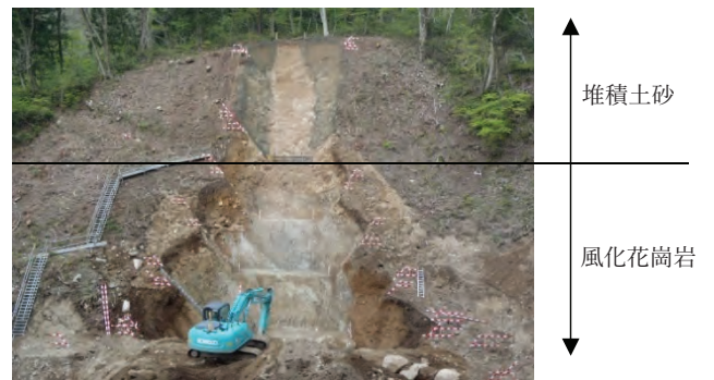
右岸側掘削状況
