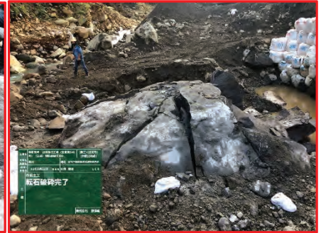
転石破碎完了
