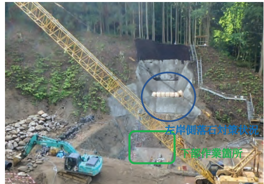
左岸側落石対策状況
