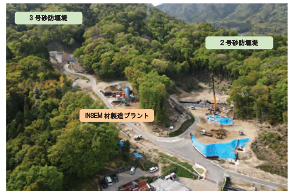
【令和4年4月末 現場全景】
