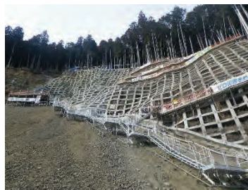
写真-7 昇降設備と材料置場
