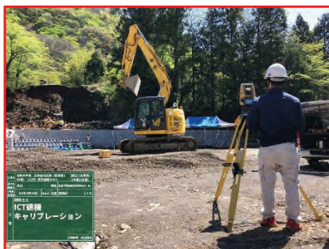
ICT建機キャリブレーション
