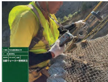
写真-19 昇降状況
