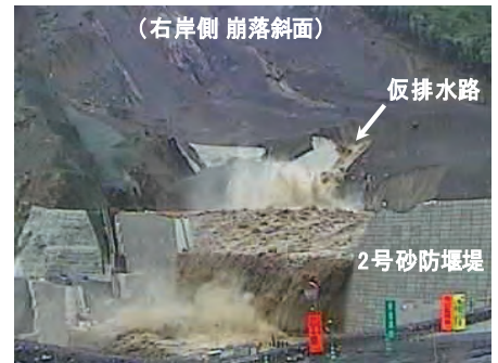
写真-1 台風11号による越流状況
