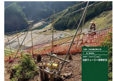
写真-20 昇降状況
