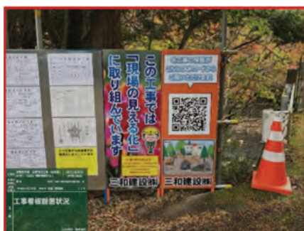
現場の見える化 看板掲示
