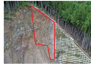
写真-12 施工箇所
