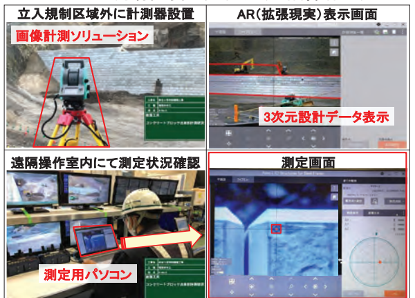
図-13 ブロック出来形測定状況(遠隔操作室)
