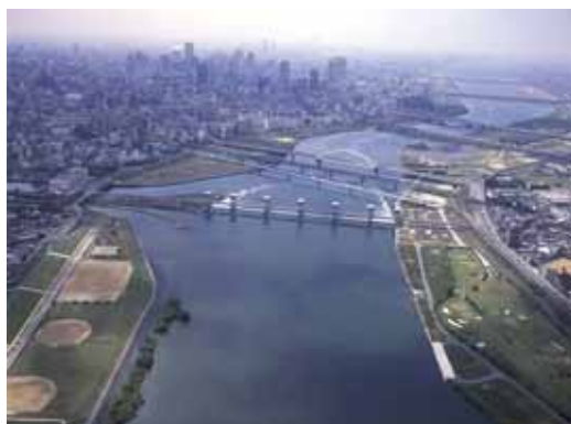
写真 3.2.3-1 淀川大堰から下流を望む
