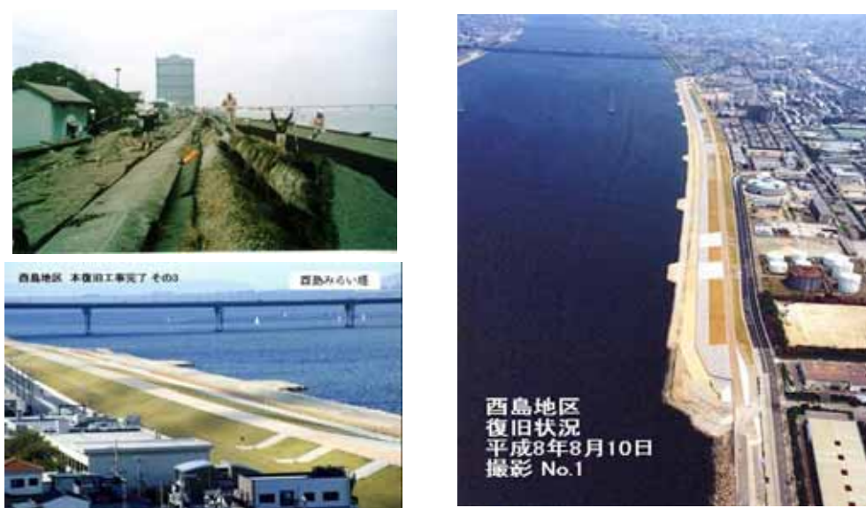
写真 3.3.3-1 西島地区災害復旧工事状況
