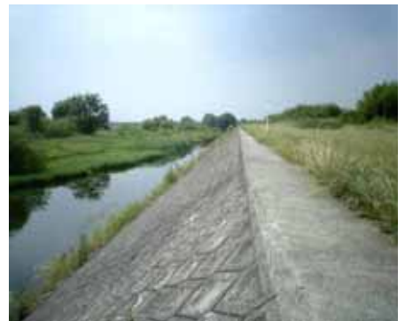
写真 3.2.7-1 コンクリート護岸
