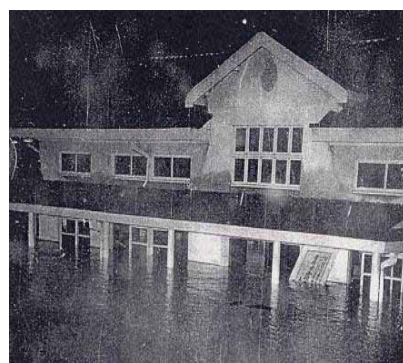
写真 3.3.1-4 亀岡駅 (昭和 28 年 9 月台風 13 号)
