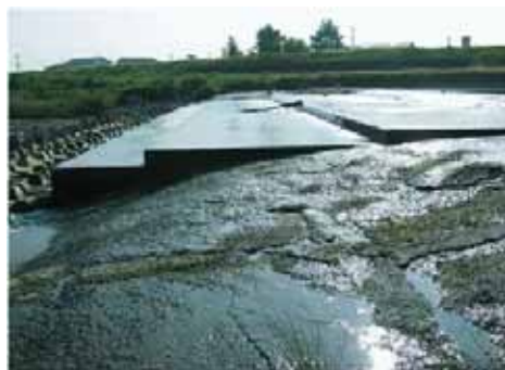
写真 3.2.1-1 魚類等の遡上阻害となっている横断工作物(高木井堰(猪名川))
