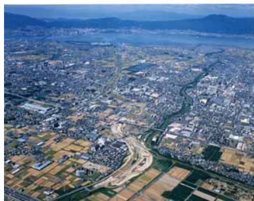
写真 3.3.1-6 草津川 （旧川と新川の分派部の様子）
