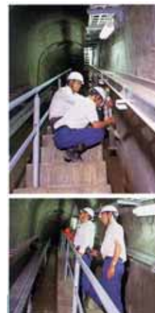
ダム本体の観測・点検状況
