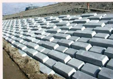
◀浸食に対する堤防補強例
