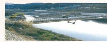
瀬田川の河床掘削状況
