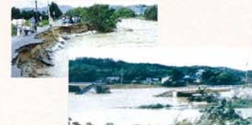
大戸川の洪水による被害の状況
