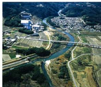
河道内樹木の状況
