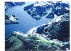
青蓮寺ダム（昭和45年管理）
