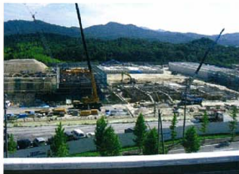
ゆめが丘浄水場の工事状況(H19.8現在)
