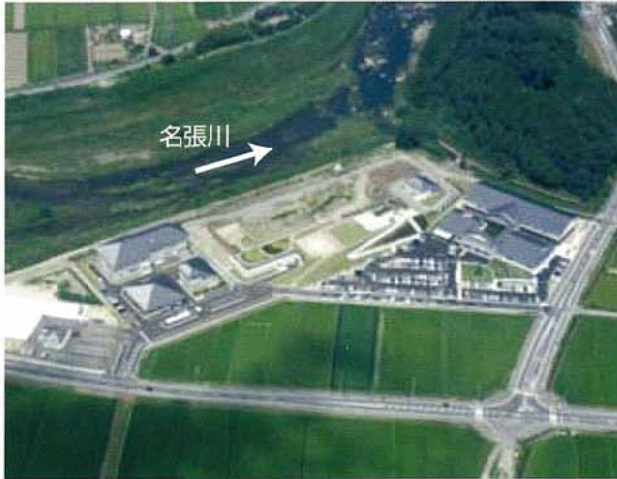
名張川防災ステーション
