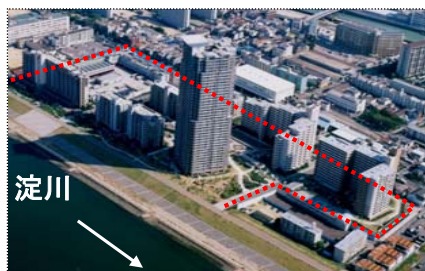
淀川左岸西島地区
