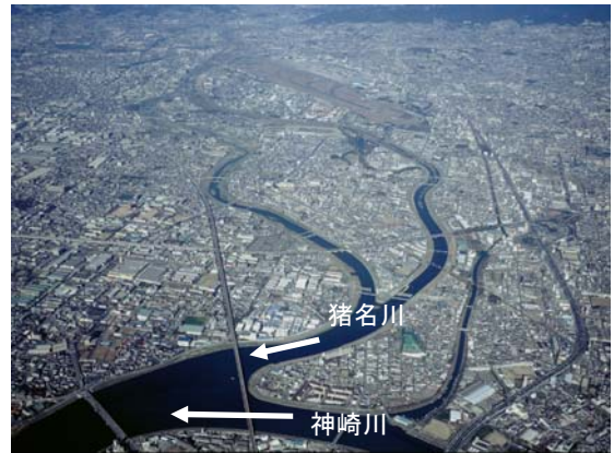
写真 2-9 猪名川・神崎川合流部
