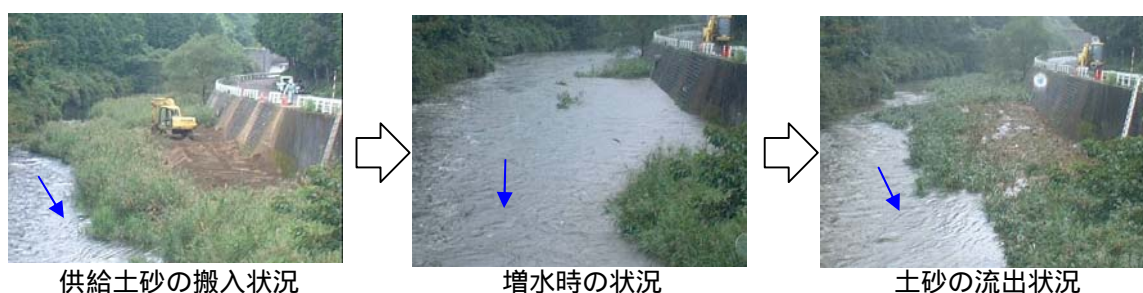
写真 4.2.5-5 布目ダム下流土砂供給試験状況
