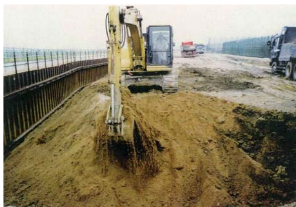
写真 3.3.1-9 木津川の堤防の状況
