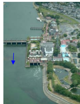
写真 4.3.2-8 瀬田川洗堰のバイパス水路
