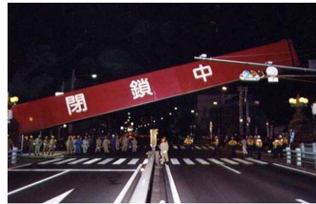
写真 3.3.2-2 淀川陸閘ゲート
