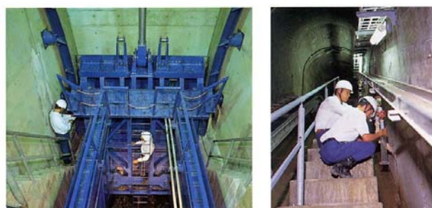
ゲートの点検状況
