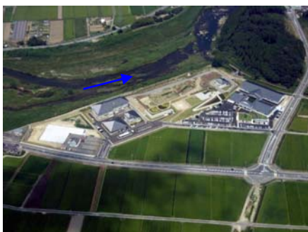
写真 4.3.2-4 名張川河川防災ステーション
