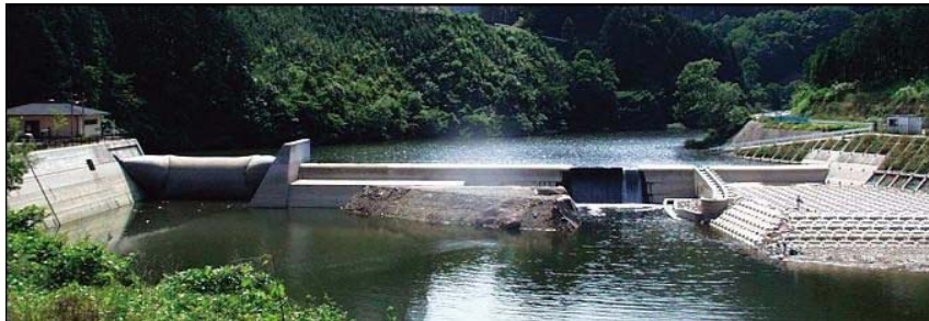
写真 4.2.5-4 副ダム（室生ダム）
