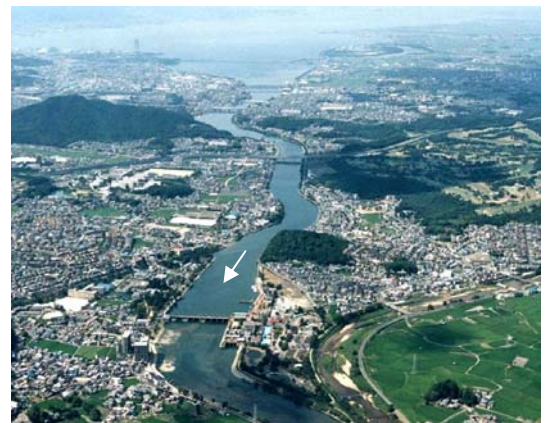
写真2-3 瀬田川(琵琶湖～瀬田川洗堰付近)
