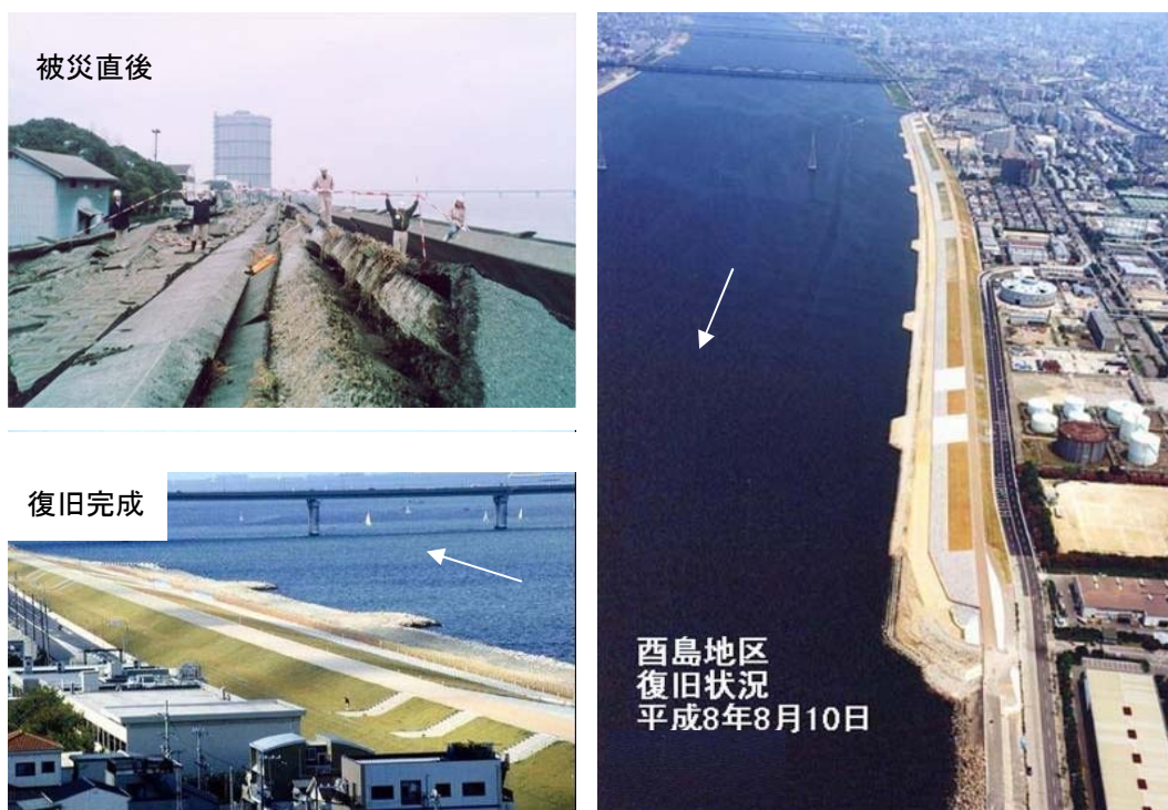
写真 3.3.3-1 西島地区災害復旧工事状況
