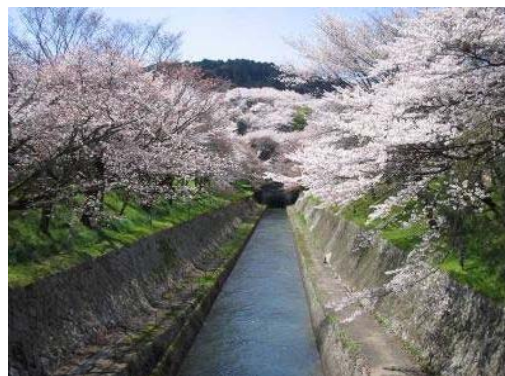
写真2-10 琵琶湖疏水の取水口
