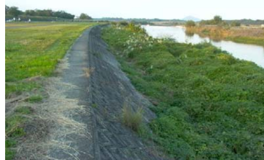
写真 3.2.7-1 コンクリート護岸
