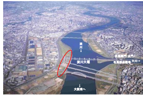
写真 4.3.4-1 淀川大堰閘門設置位置
