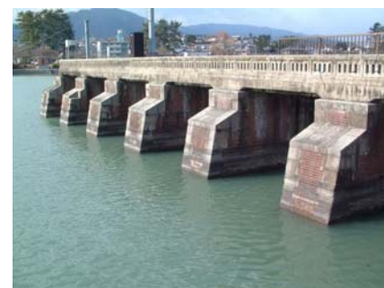
写真 4.6.2-4 旧瀬田川洗堰(南郷洗堰)
