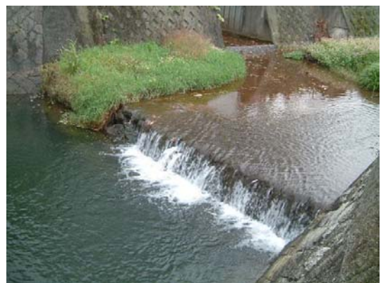
写真 4.2.3-9 瀬田川 流入支川合流部
