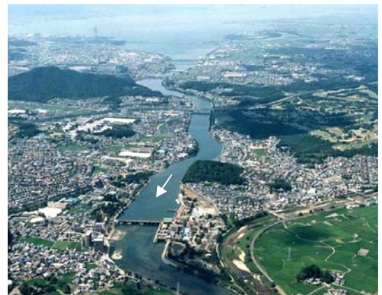
写真2-3 瀬田川(琵琶湖～瀬田川洗堰付近)
