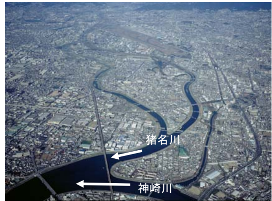
写真 2-9 猪名川・神崎川合流部
