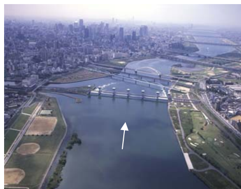
写真 3.2.3-1 淀川大堰から下流を望む
