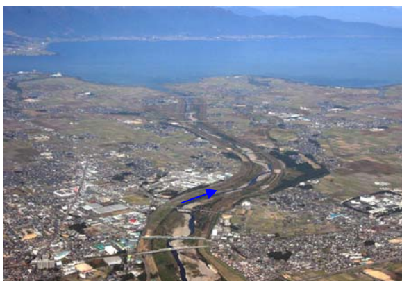
写真 3.3.1-5 野洲川(放水路区間)
