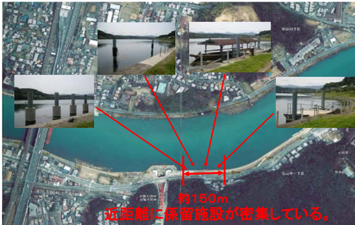
写真 3.2.7-2 瀬田川における係留施設の設置状況 (右岸 73.1km 付近)
