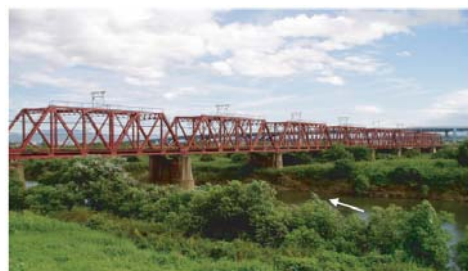
写真 3.6-2 河道内樹木の繁茂状況(木津川)
