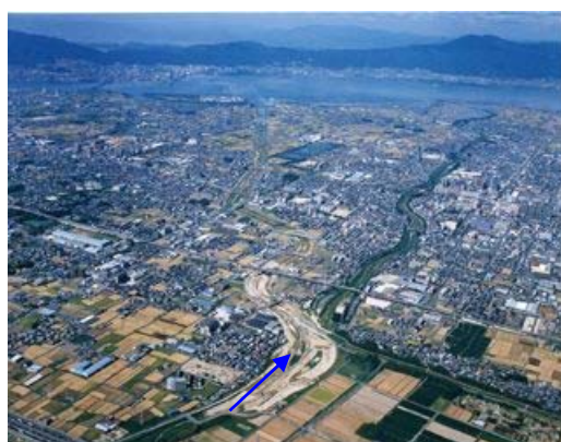
写真 3.3.1-6 草津川(分派部)
