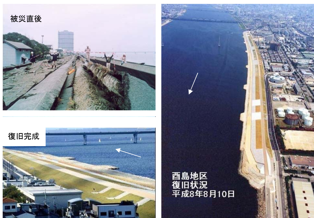
写真 3.3.3-1 西島地区災害復旧工事状況
