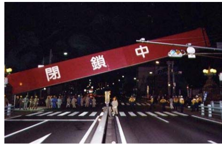
写真 3.3.2-2 淀川陸閘ゲート
