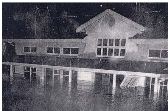
写真 3.3.1-4 亀岡駅 (昭和28年9月台風13号)
