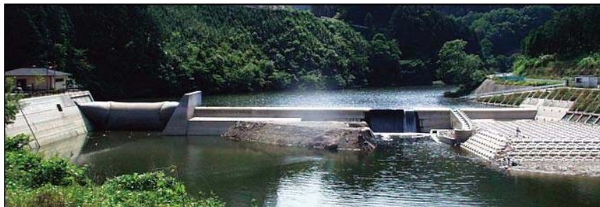
写真 4.2.5-4 副ダム（室生ダム）
