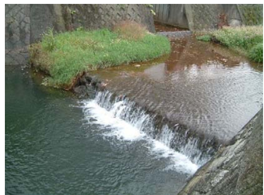
写真 4.2.3-9 瀬田川 流入支川合流部
