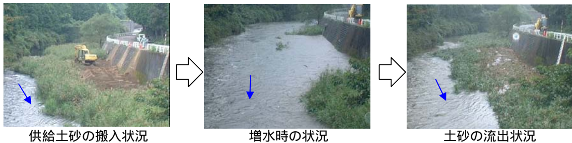
写真 4.2.5-5 布目ダム下流土砂供給試験状況
