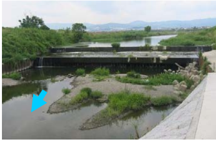
写真 4.2.3-7 縦断方向の河川形状の修復 (芥川1号井堰)
