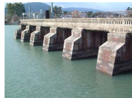
写真 4.6.2-4 旧瀬田川洗堰(南郷洗堰)
