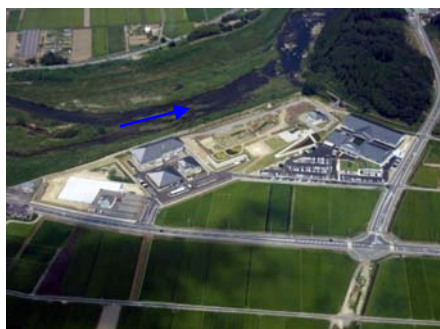
写真 4.3.2-4 名張川河川防災ステーション
