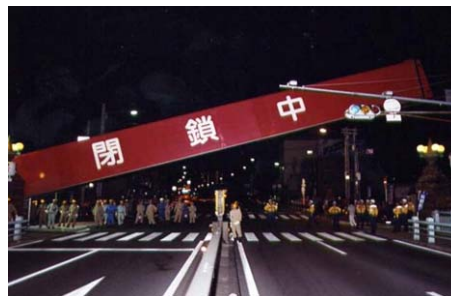
写真 3.3.2-2 淀川陸閘ゲート
