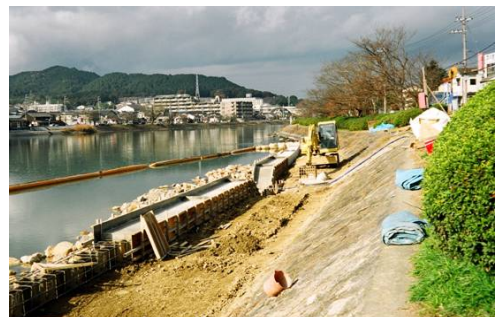
写真 4.2.6-1 工事中の濁水対策の事例 (汚濁防止フェンスの設置)
