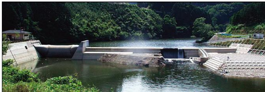
写真 4.2.5-4 副ダム（室生ダム）
