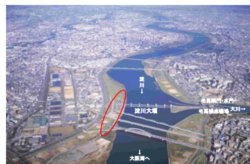
写真 4.3.4-1 淀川大堰閘門設置位置
