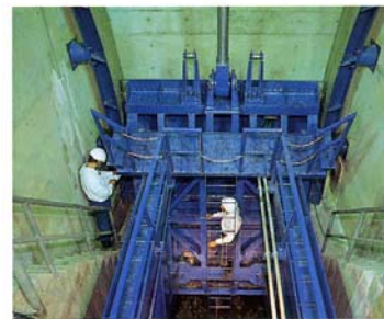
ゲートの点検状況
