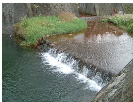
写真 4.2.3-9 瀬田川 流入支川合流部
