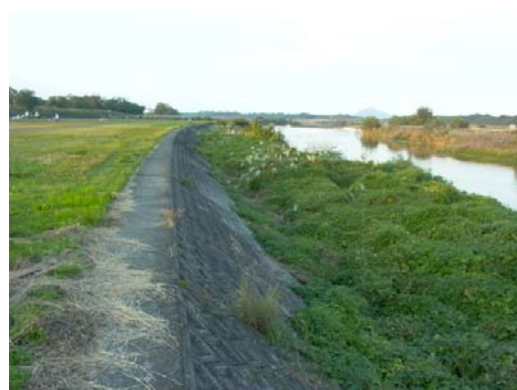
写真 3.2.7-1 コンクリート護岸
