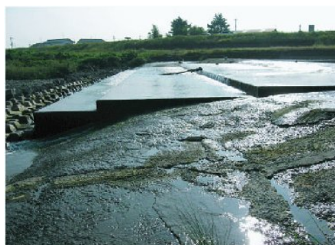
写真 3.2.1-1 魚類等の遡上・降下の阻害となっている横断工作物 高木井堰（猪名川）
