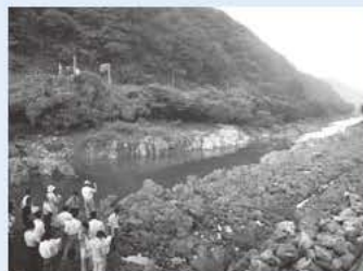
鹿跳峡谷（狭窄部の状況）
