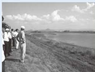
野洲川河口付近（横断形状の修復状況）
