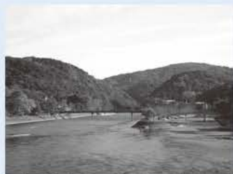
宇治川塔の島地区（流下能力が低い箇所）
