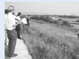
下津屋地区（堤防補強区間）
