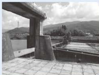
高時川頭首工
