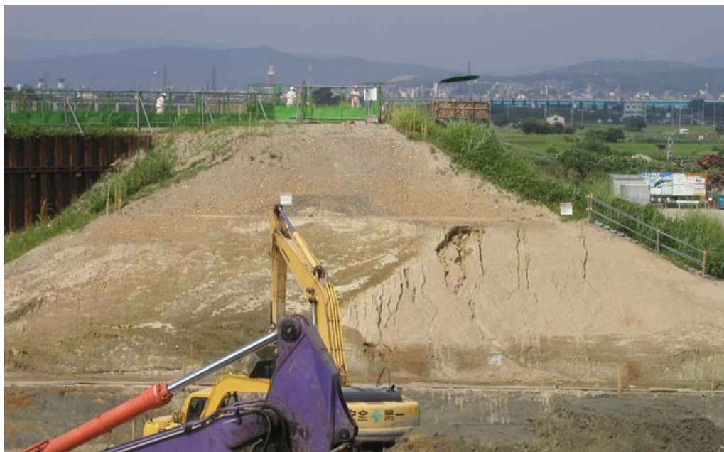
巨椋池排水機場付近の堤防開削状況の写真
