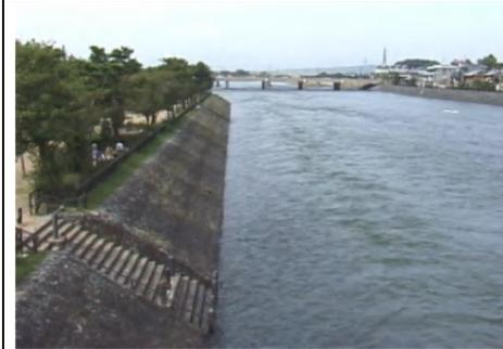
④ 掘削後の橋島。急斜面の護岸をつくったために2件の転落・死亡事故が発生。流心が護岸のすぐそばを流れる危険な状態。
