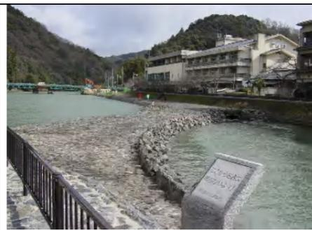
⑪ 塔の川締切堤（2億円）。鵜飼船は本川に出られず。導水管からの毎秒3m<sup>3</sup>/sの流入水では塔の川の環境が悪化、藻の異常繁殖と悪臭。喜撰橋からの景観も悪化。流下能力低下。
