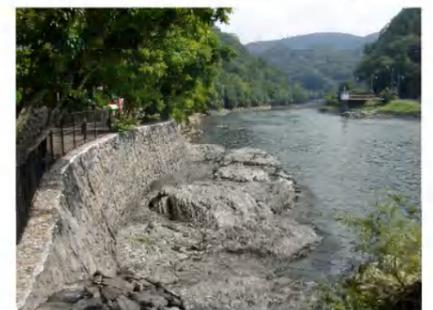
フォトモンタージュ 河床掘削時 [本川約0.4m河床掘削]
