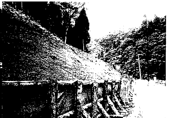
ダムサイト付近
