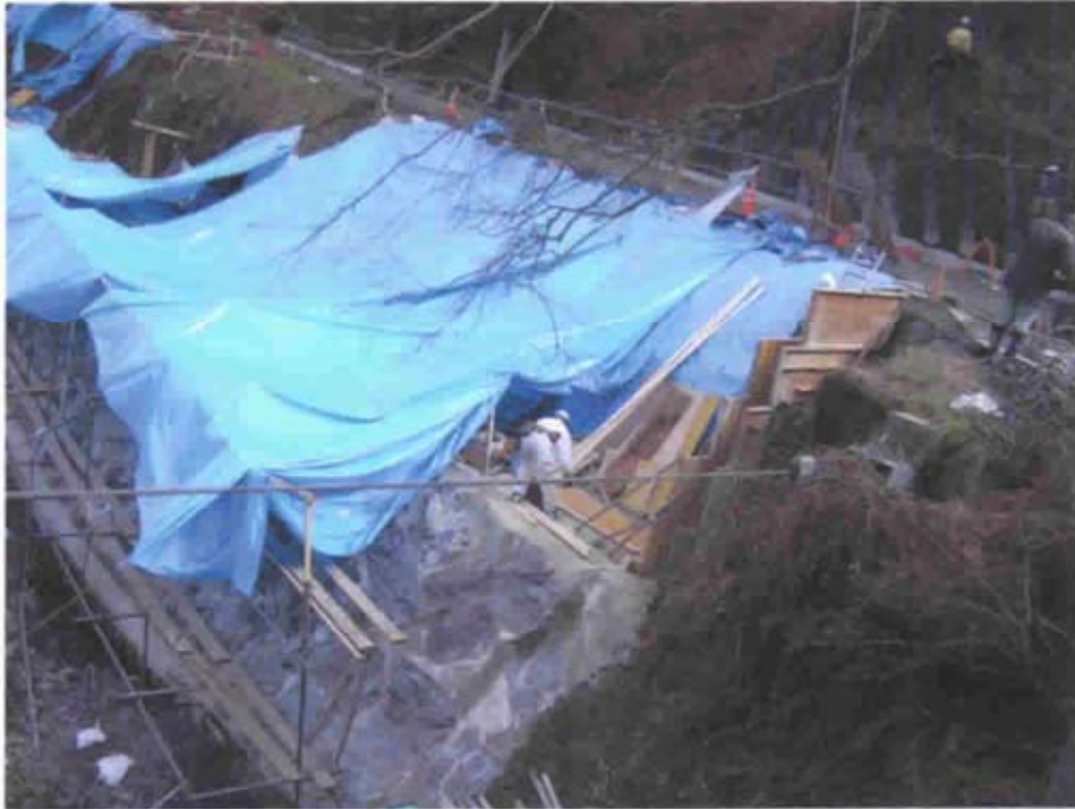
(13) 天ヶ瀬ダム再開発・大トンネル工事に伴う道路拡幅工事(天ヶ瀬吊橋直上流左岸)。 自然の岩石の岸に模造の護岸パネルを貼り付けている。
