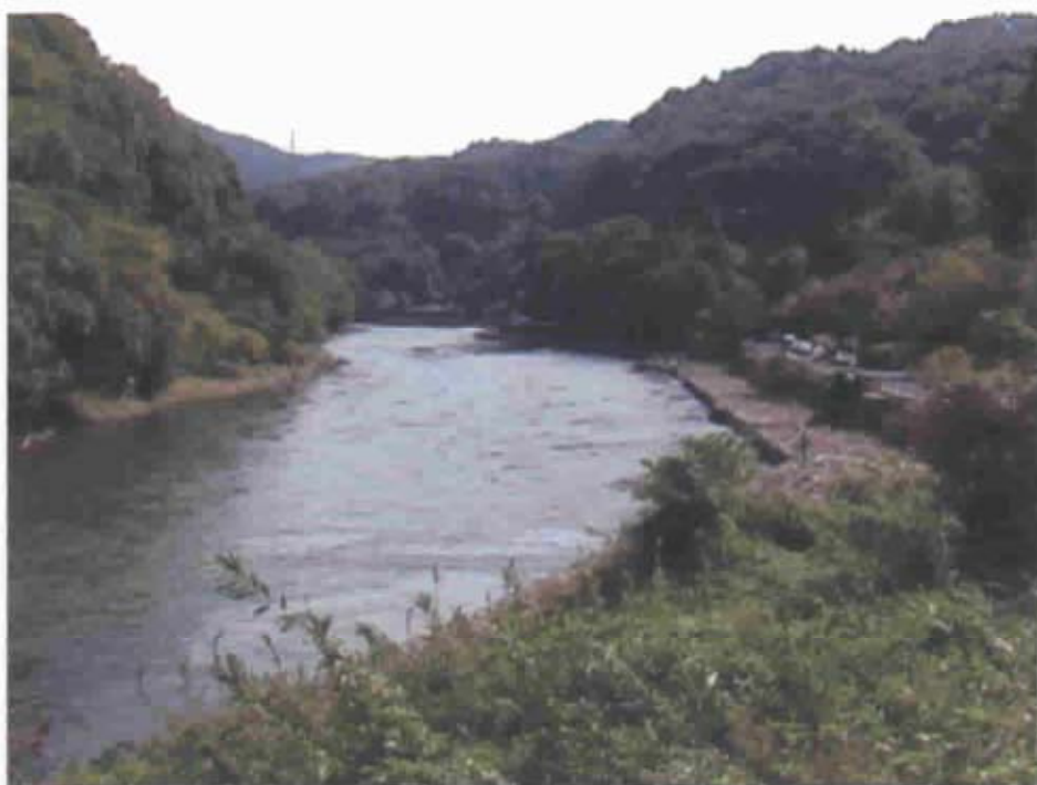
写真（7）白川浜(左岸)・導水管敷設によって石とコンクリートで固められた
