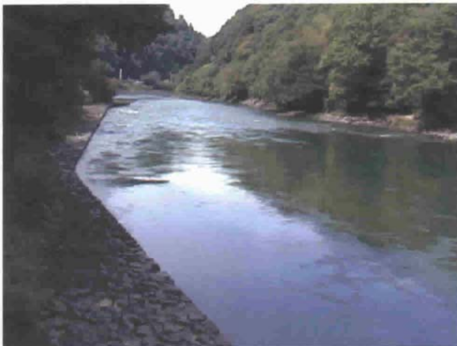
写真（5）天ヶ瀬吊橋下流。右岸は自然の岸、左岸は導水管の石積み
