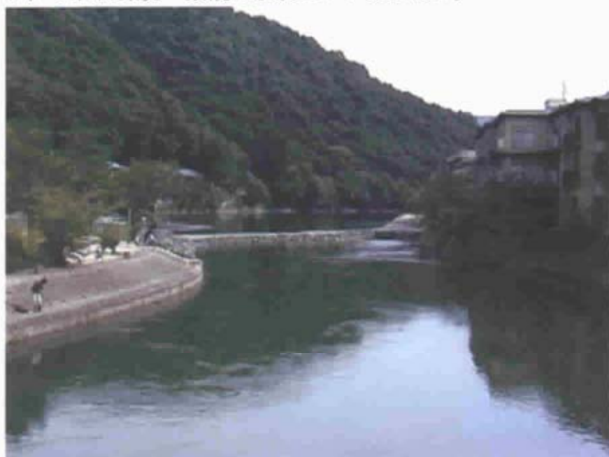
写真（1）喜撰橋から上流の景観・縮切堤と導水管
