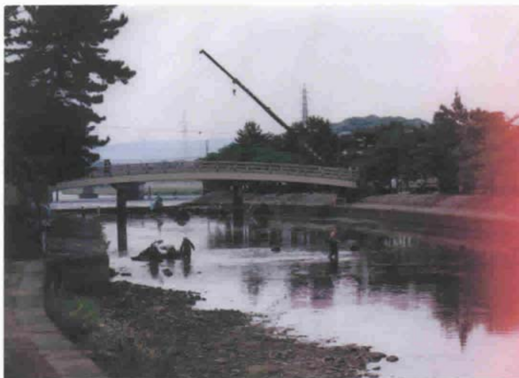
写真（3）塔の川の繁茂した藻の撤去作業・橋樑
