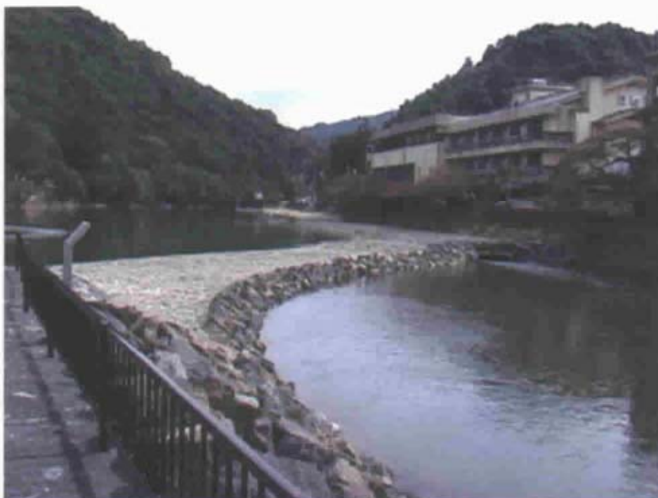
写真（2）塔の島の石積み締切堤
