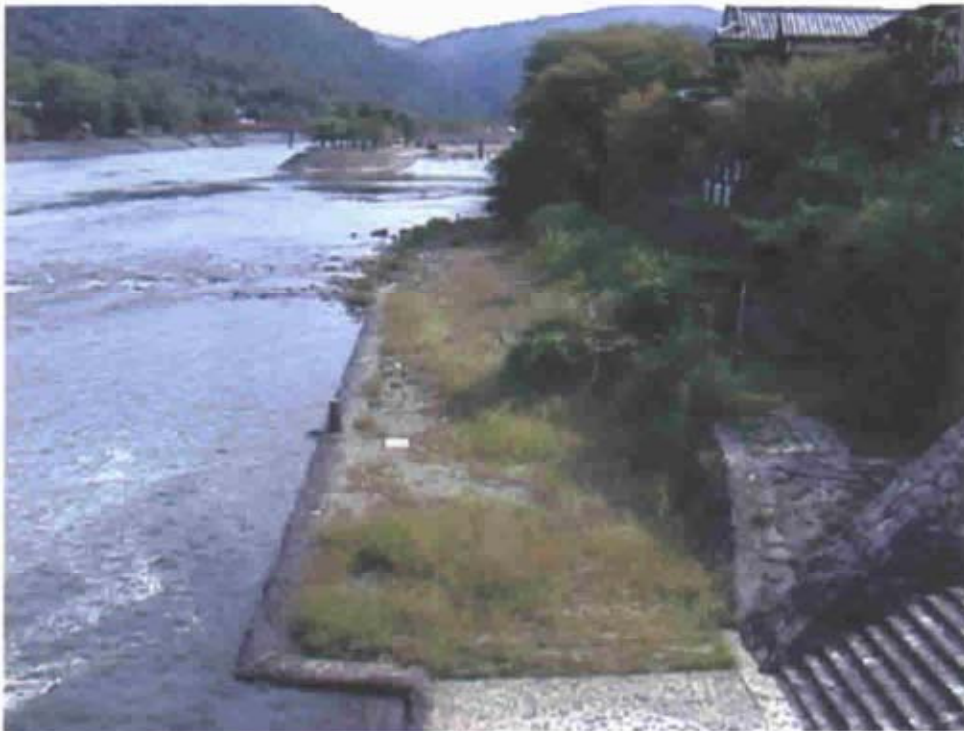
(10) これもなぜか川を石で埋め立てた宇治橋上流・左岸。 元は階段の下までが川であった。
