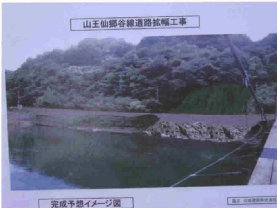
(14) 天ヶ瀬吊橋直上流の道路拡幅工事の看板 (完成予想図)
