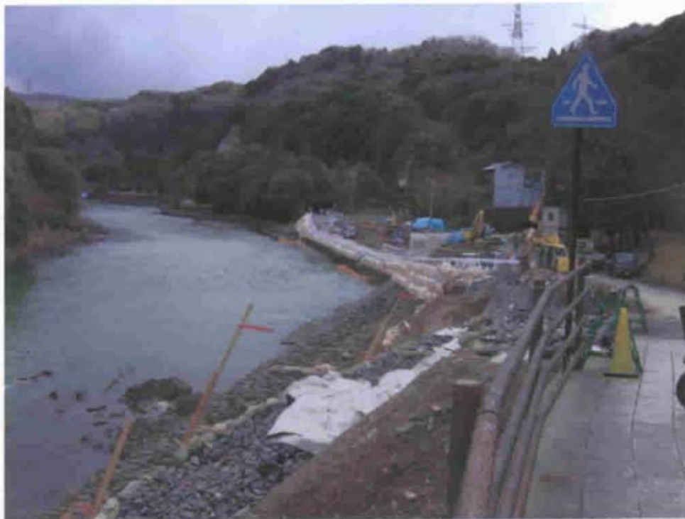
(12) 白川浜・天ヶ瀬ダム再開発・大トンネル工事に伴う道路拡幅工事
