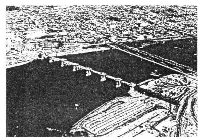
紀の川大堰(建設中)
