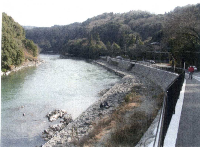
導水管敷設と道路拡幅で白川浜はコンクリートの下に。
