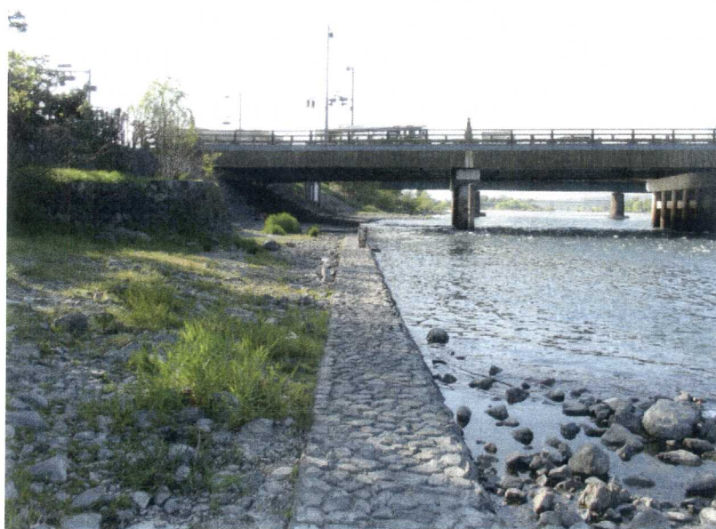
宇治川を埋め立てた塔の川床止め工事場所から宇治橋を見る
