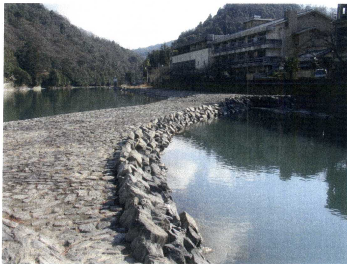
締切堤 建設費用2億円
