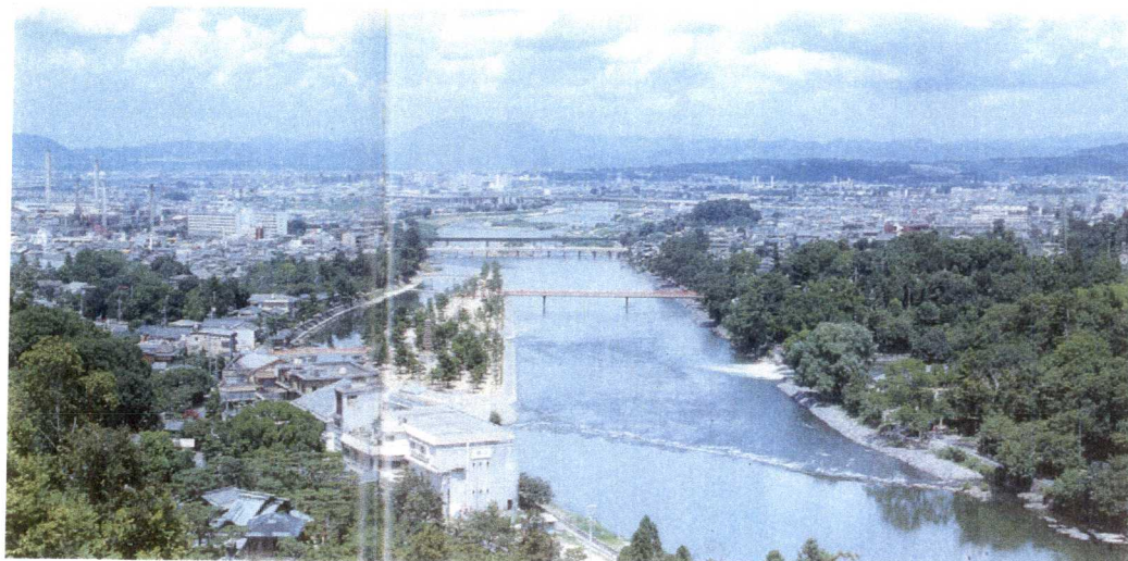
平成元年頃の宇治川・塔の島周辺。塔の島と橘島の東半分が削減され、護岸は直線化し、45度の傾斜
