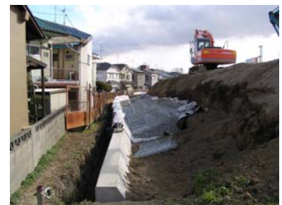
堤防の補強工事(H17年度)
