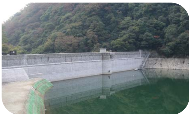
写真3-3. 布引五本松ダムの補強
