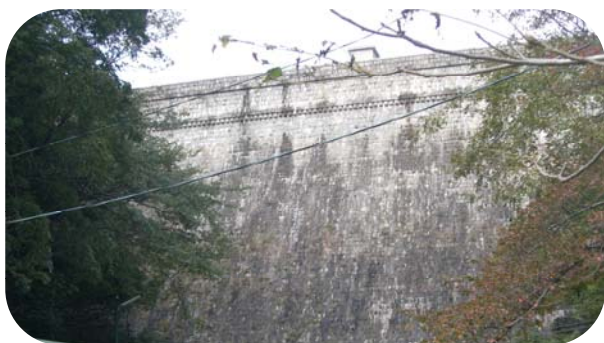
写真3-1. 布引五本松ダム
