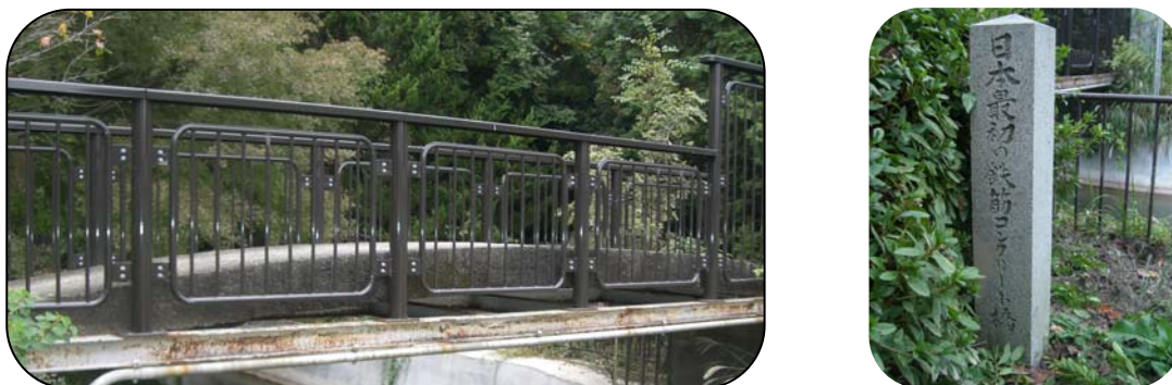
図 3-5. 日本最古の鉄筋コンクリート橋 (京都市山科区日ノ岡)
