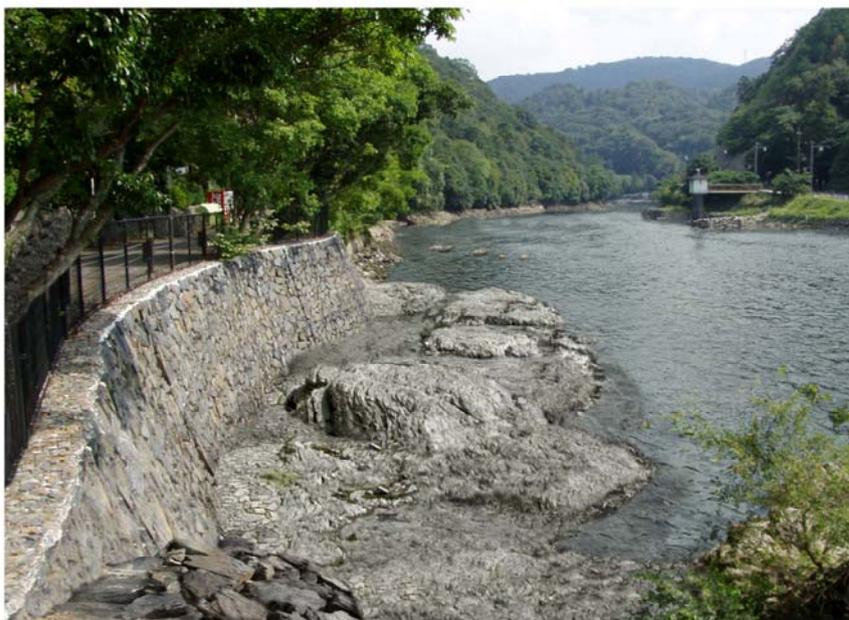
フォトモンタージュ 河道掘削時 [本川約 0.4m河道掘削]
