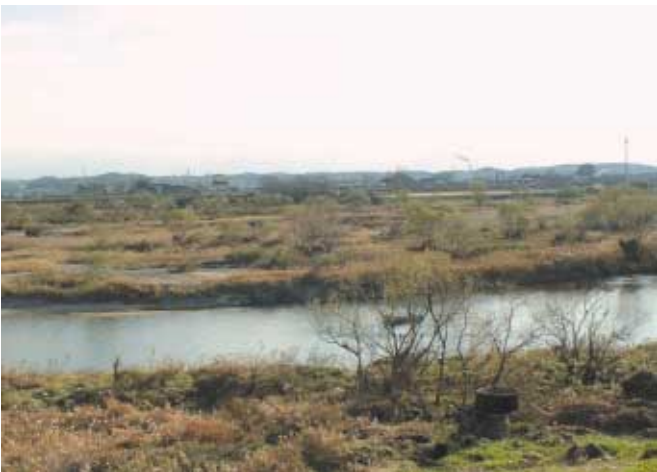
旧泉大橋(潜没橋予定地)
