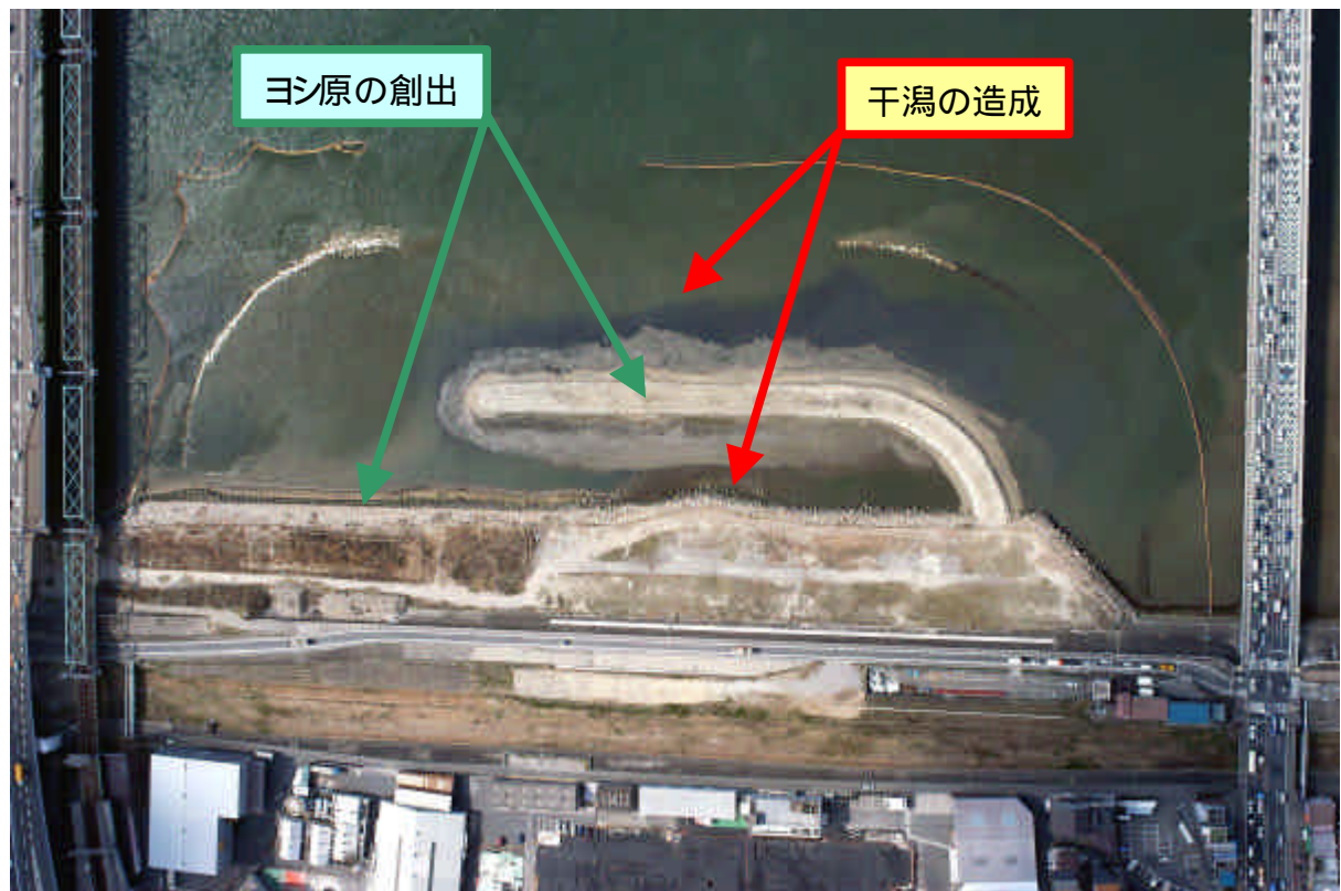
海老江写真 (工事中)
