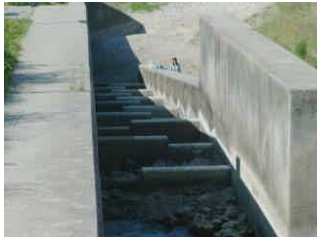
水がない状態
