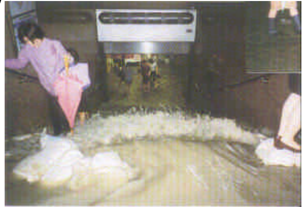
地下街での浸水状況
