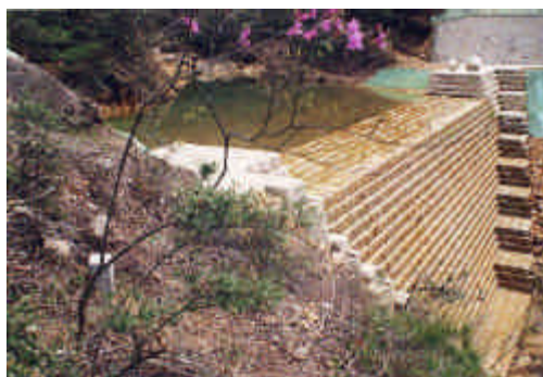
砂防堰堤の設置
