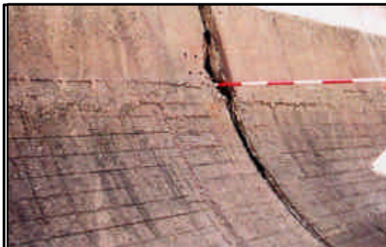
特殊堤川側法面
