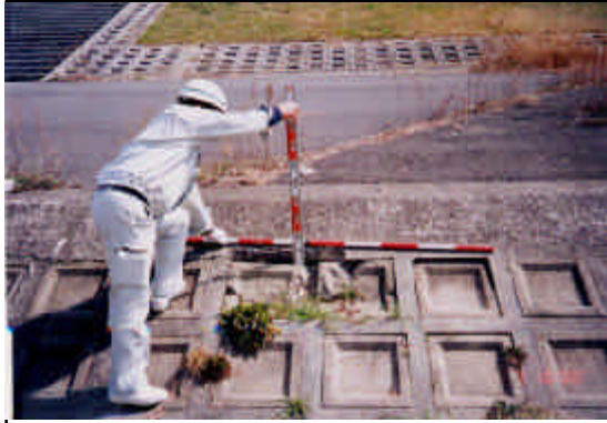
護岸の陥没
