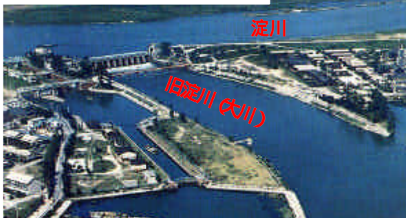
S47.4 淀川大堰着工前の状況
