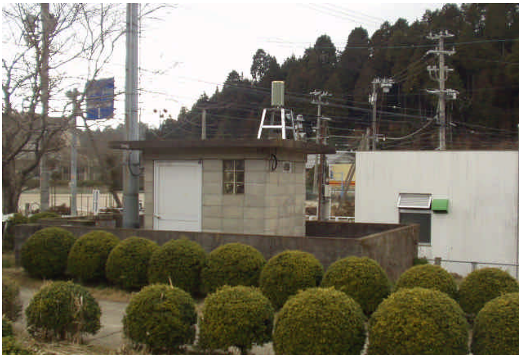
西別院雨量観測所
