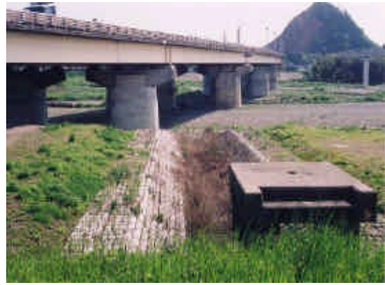
存置された排水樋管の一部
