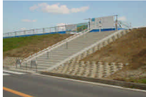
飛び出し防止施設
