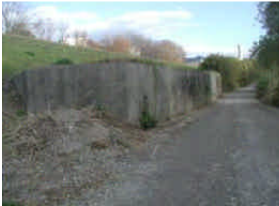
存置された取水施設の一部
