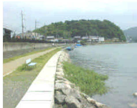
高水敷散策路整備状況
