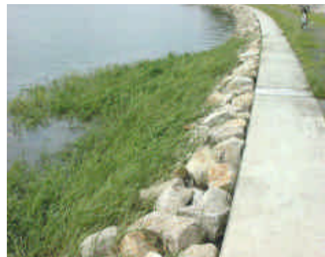
捨石設置状況
