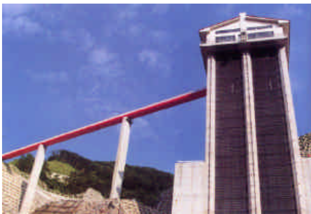
選択取水設備の例 2門の直線多段式ゲート(7m x 5段扉)
