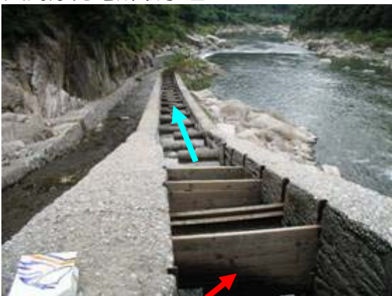
大河原発電所取水堰
