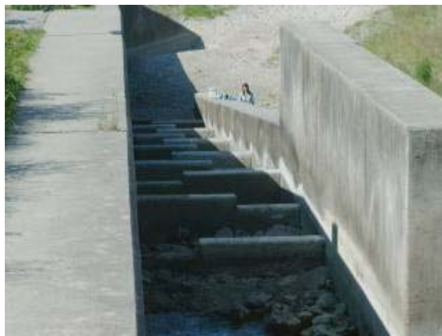
水がない状態
