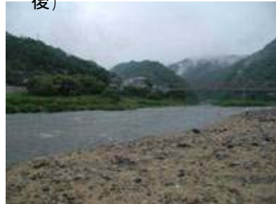
左岸下流より上流を望む(放流後) 下流(笠置)において約24cmの水位上昇が確認された
