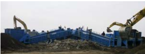
生態系に配慮した新機種機械 鵜殿における土質改良
