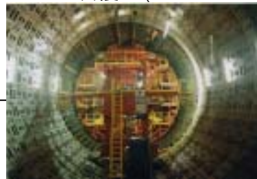
二次覆工(セント)
