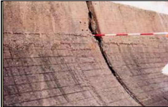
特殊堤川側法面
