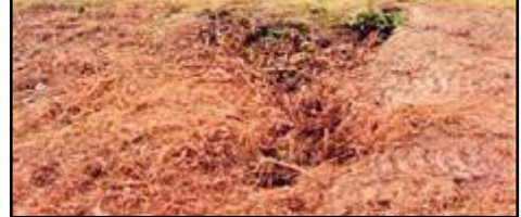
モグラによる堤防法面の損傷事例
