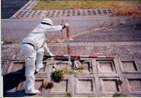
護岸の陥没
