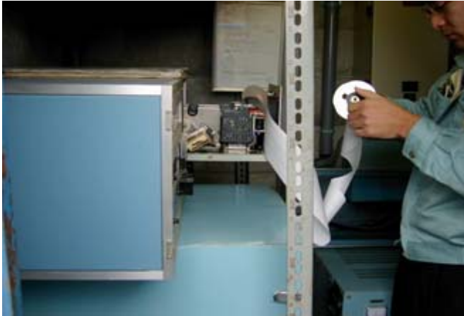
水位観測所内部 (自記紙の点検状況)
