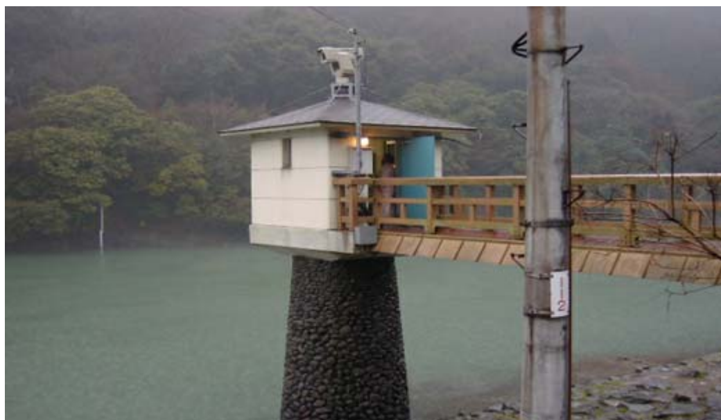
槇尾山水位観測所
