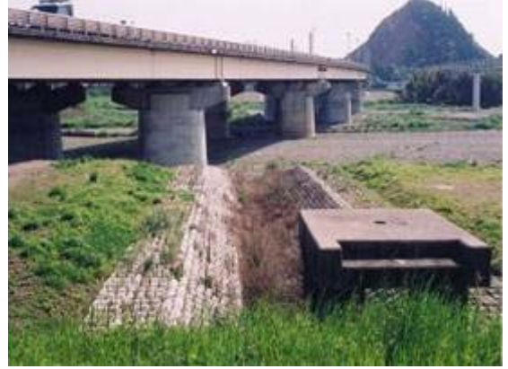
存置された排水樋管の一部
