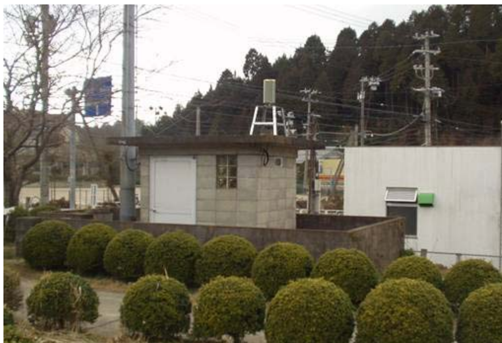
西別院雨量観測所
