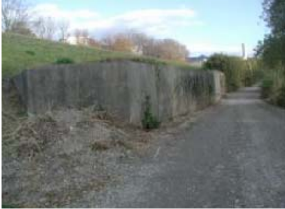
存置された取水施設の一部
