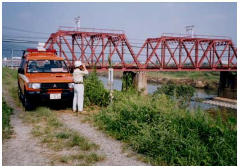
河川巡視の状況
