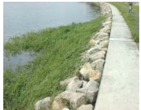
捨石設置状況
