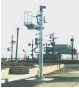
河川監視用カメラ装置
