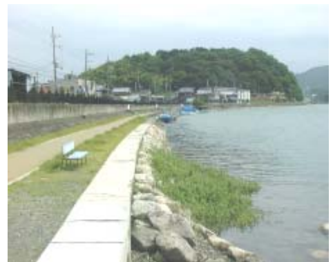
高水敷散策路整備状況
