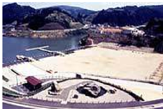
公園整備(布目ダム)
