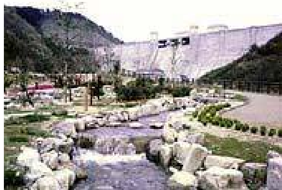
公園整備(比奈知ダム)
