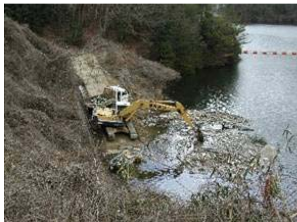
流木の引き上げ状況
