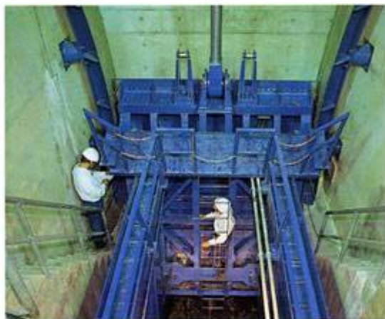
ゲートの点検状況
