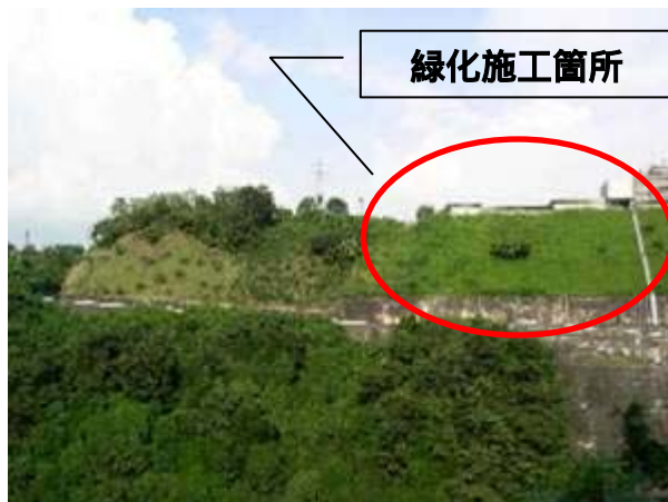
緑化された法面の状況
