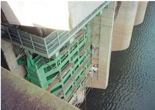
腐食防止のためのゲート塗装状況
