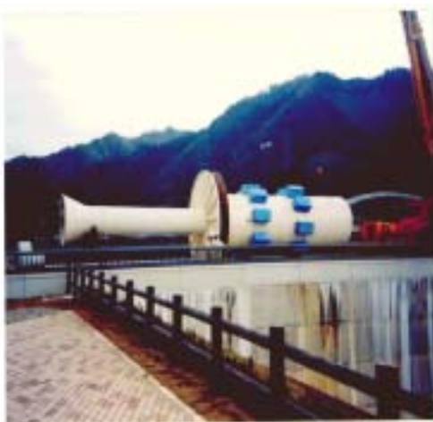
深層曝気設備(設置前)
