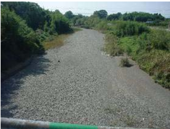
瀬切れ発生 (H14.10.13)
