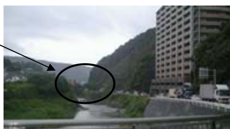
銀橋より下流側を撮影
