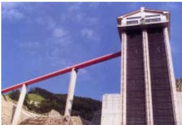
選択取水設備の例
