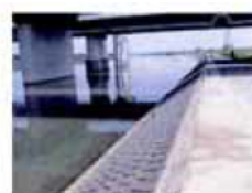
鳥飼大橋治水護岸工
