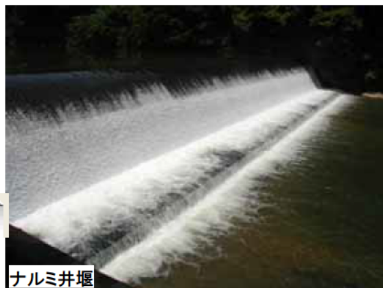
●魚道があるものの落差が約0.3mあり 魚類等の遡上・降下が困難である。
