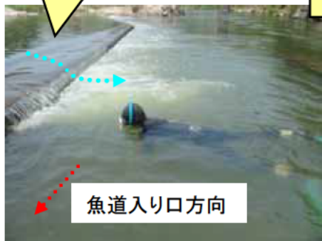
相楽発電所井堰 副堰堤の現状
