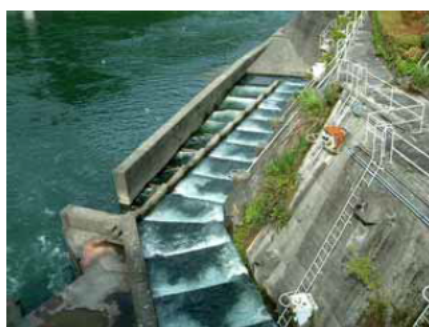
写真-1 階段形式の魚道例
