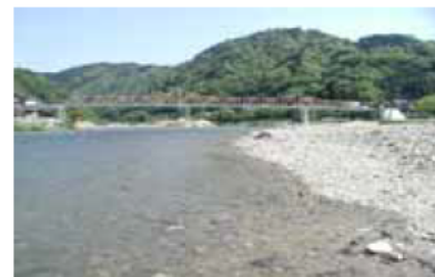
左岸下流より上流を望む(放流中)
