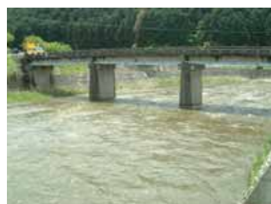
右岸下流より下流を望む(放流中)
